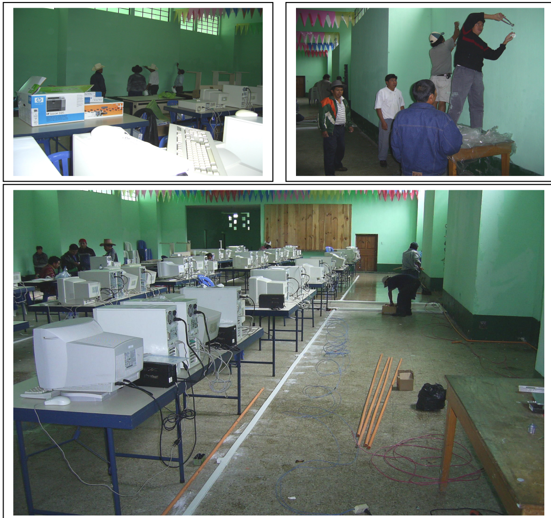
Figura 61. La adecuación del local y las instalaciones eléctricas del CCD también fueron realizadas por personas de la comunidad de San Juan La Laguna, Sololá.
