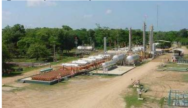
Figura 5. Vista general planta de proceso Xan, San Andrés, Petén
