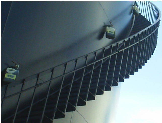
Figura 6. Puntos de muestreo de petróleo en tanque de almacenamiento
