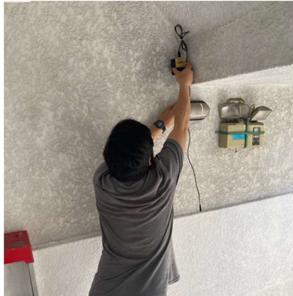
Figura 43. Colocación de sensores en estructura
