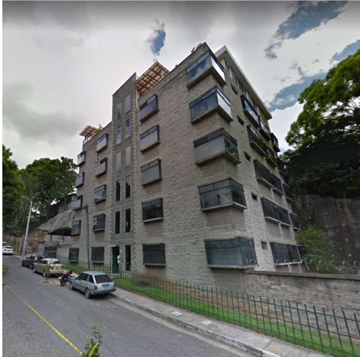
Figura 13. Edificio monitoreado por arreglo de sensores
