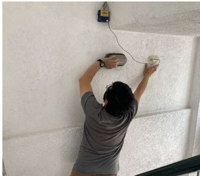
Figura 15. Instalación de sensores en estructura
