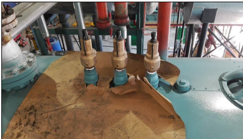
Figura 62. Instalación de válvulas de seguridad
