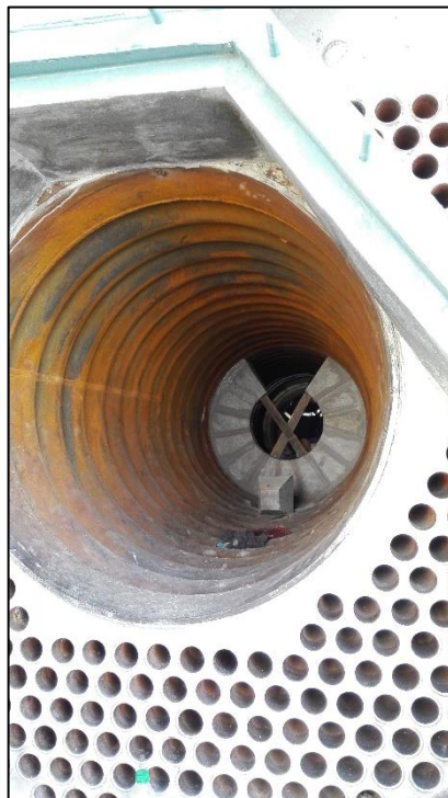
Figura 61. Instalación de ladrillos refractario rompefuego
