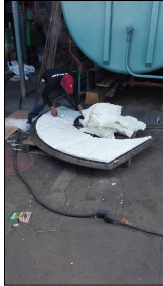
Figura 59. Instalación de fibra aislante en puertas delanteras
