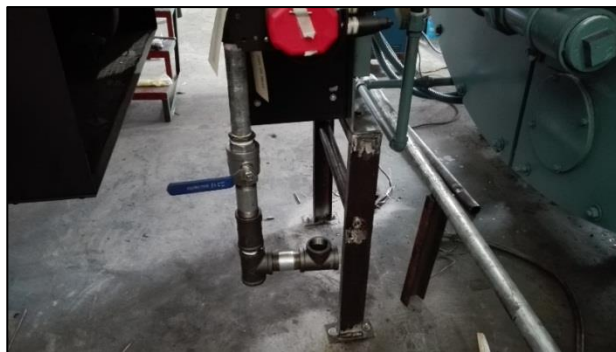
Figura 68. Instalación de base o soporte del cuerpo del quemador
