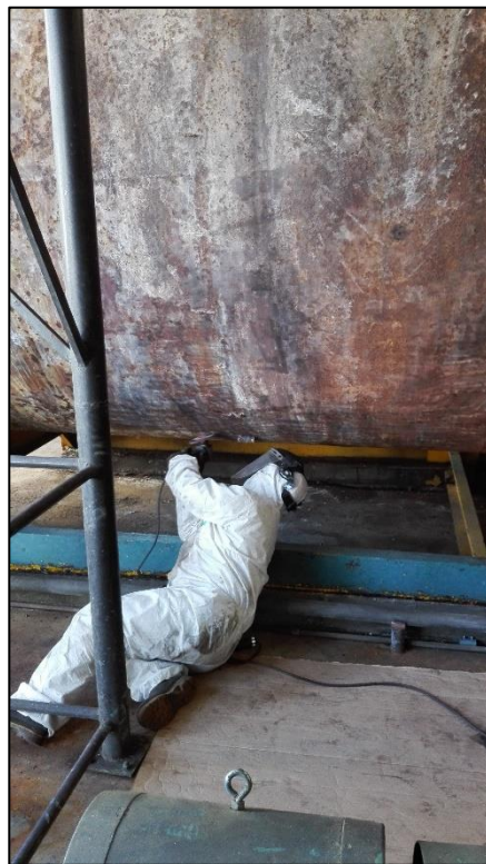
Figura 20. Limpeza de cilindro cepillado con pulidora
