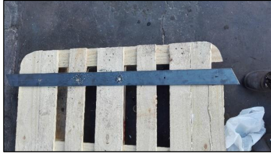
Figura 39. Fabricación de bases para pernos en caldera
