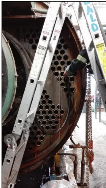
Figura 17. Limpieza de tubos
