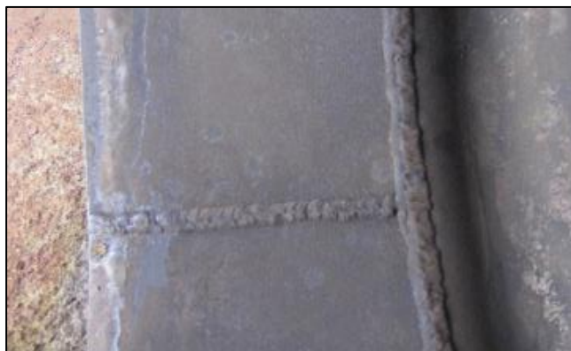
Figura 9. Cordón de soldadura por reparación
