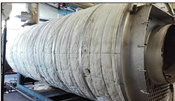
Figura 34. Finalización de proceso de instalación de fibra aislante
