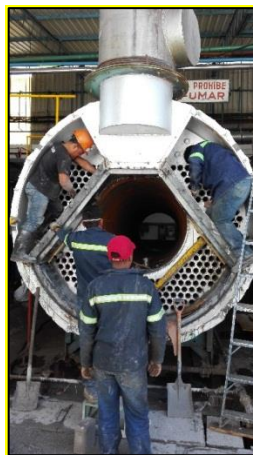
Figura 47. Fundición de refractario final de primer paso
