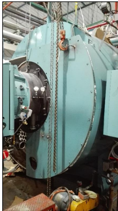
Figura 64. Montaje de puertas delanteras
