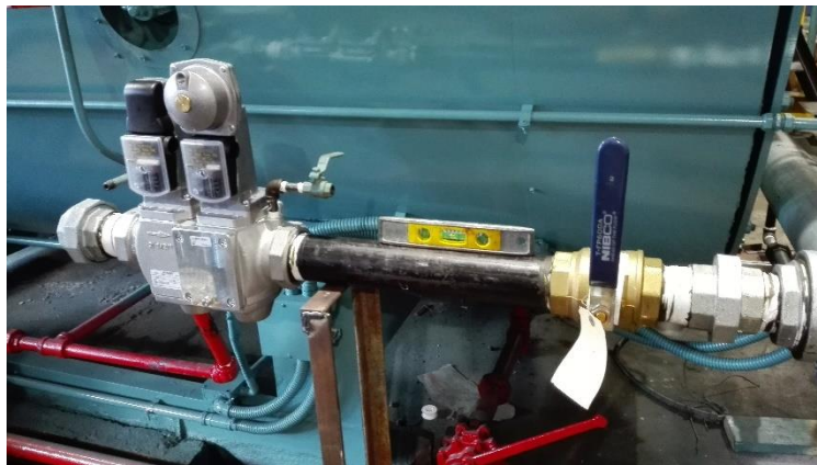
Figura 69. Instalación de sistemas de control entrada de GLP
