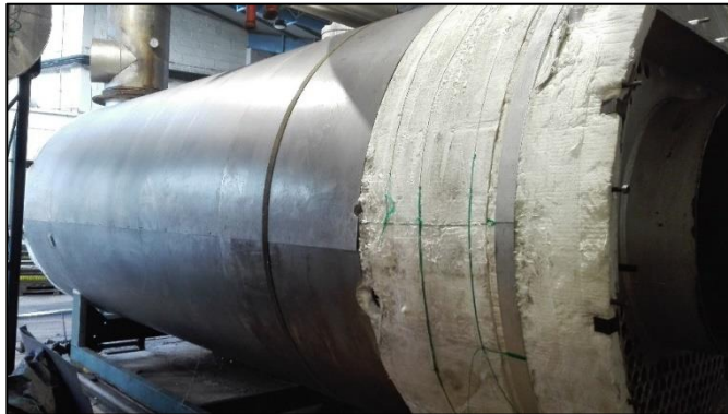
Figura 49. Instalación de recubrimiento de lámina
