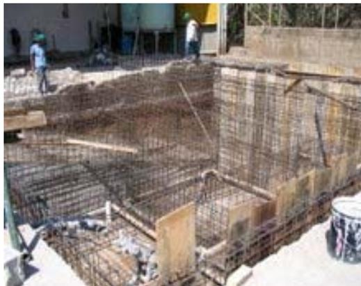
**Figura 11. Tres tanques de cemento**
