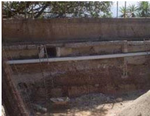
**Figura 10. Reforzamiento de los tanques**
