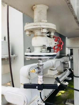
Figura 35. Sonda totalmente Instalada en la válvula
