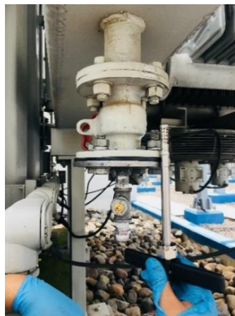
Figura 32. Ajuste de cuerpo de montaje y tuerca de cierre
