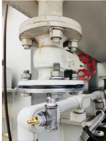
Figura 31. Válvula para purgar el aire
