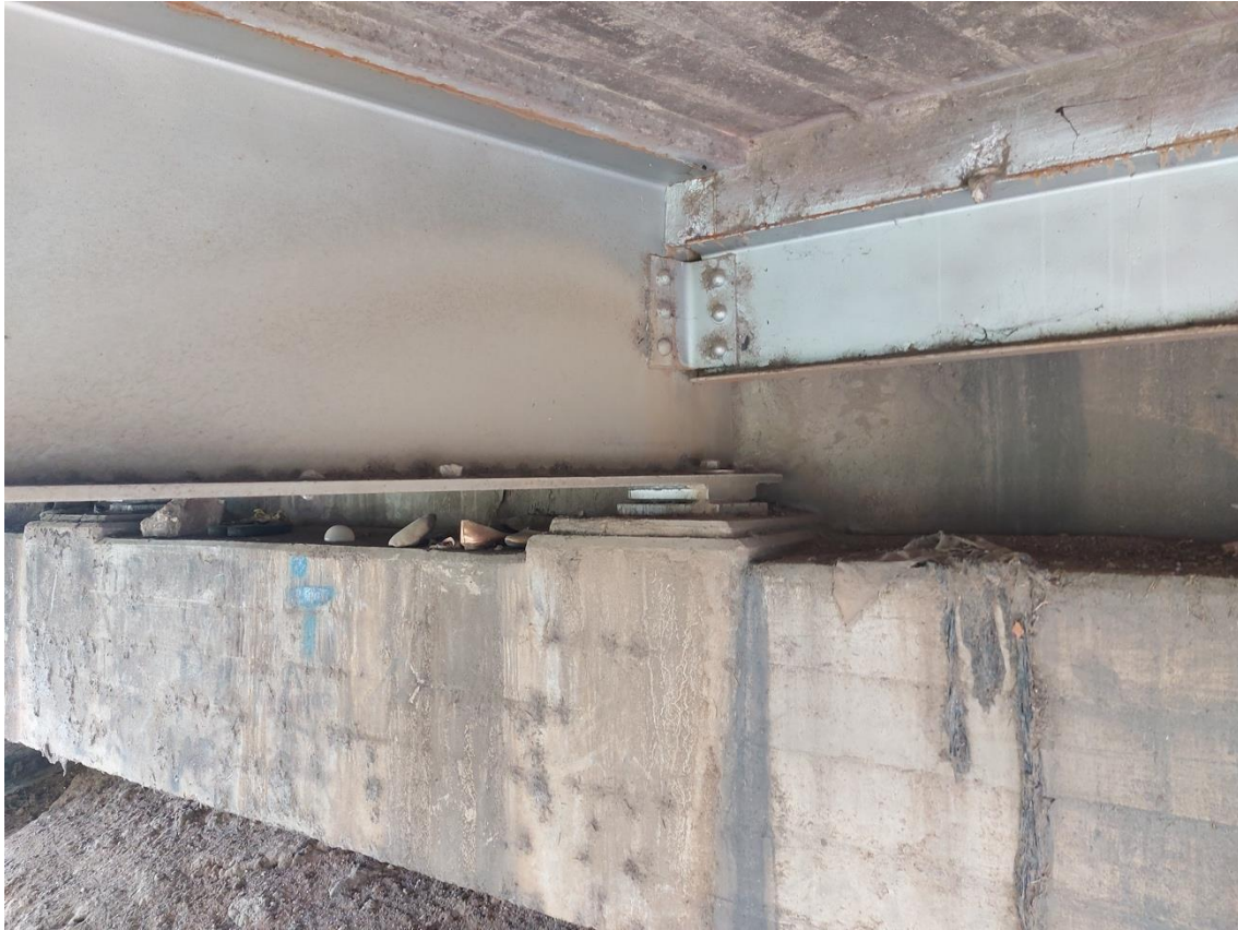
Figura 22. Puente Viñas ruta CA-01-Oriente kilómetro 45+400
