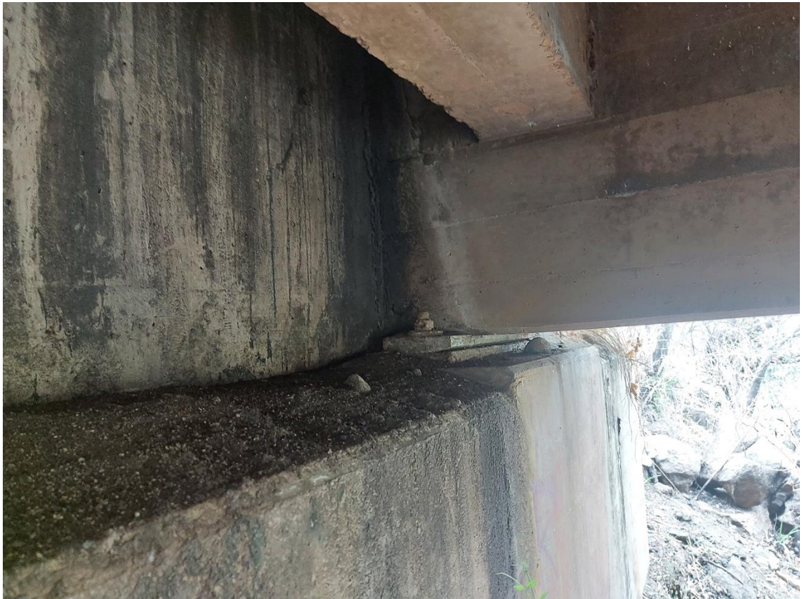
Figura 23. Puente las Pozas CA-01-Oriente kilómetro 129+800
