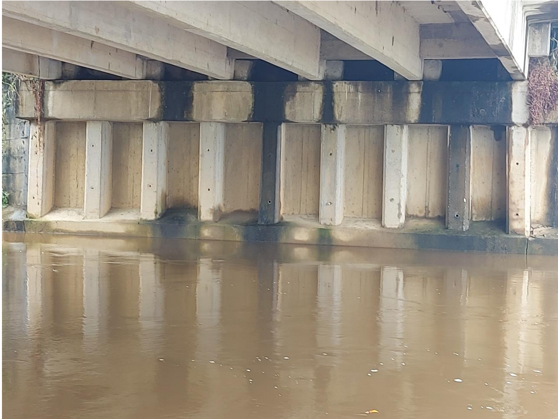
Figura 24. Puente Colón ruta CA-13 kilómetro 305+340
