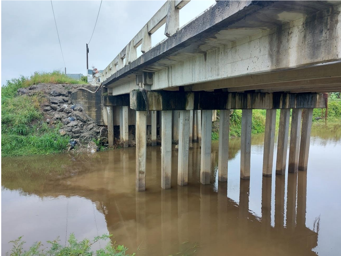
Figura 26. Puente Chajinchas CA-13 kilómetro 288+993
