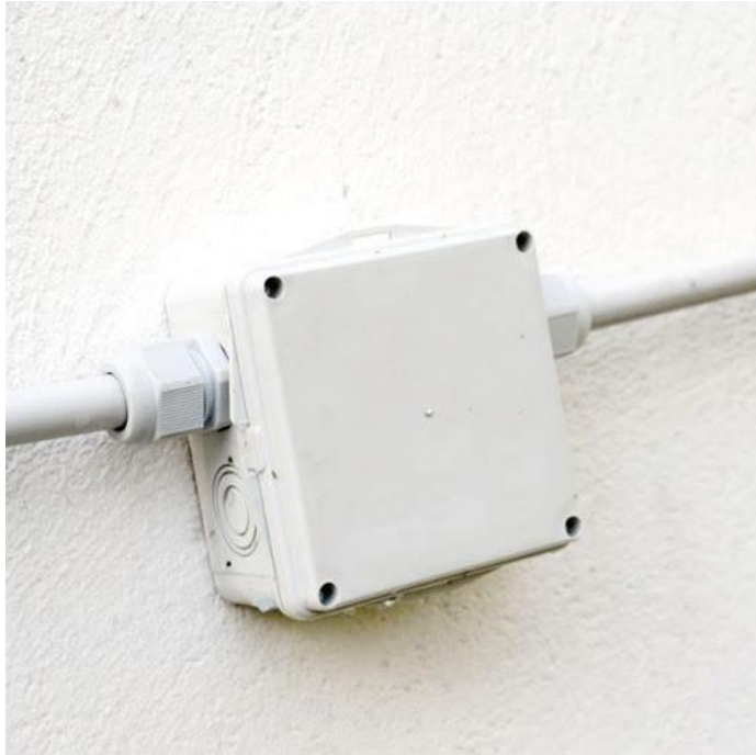
Figura 26. Forma sugerida de instalar caja de registro
