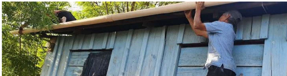
Figura 15. Instalación de canal
