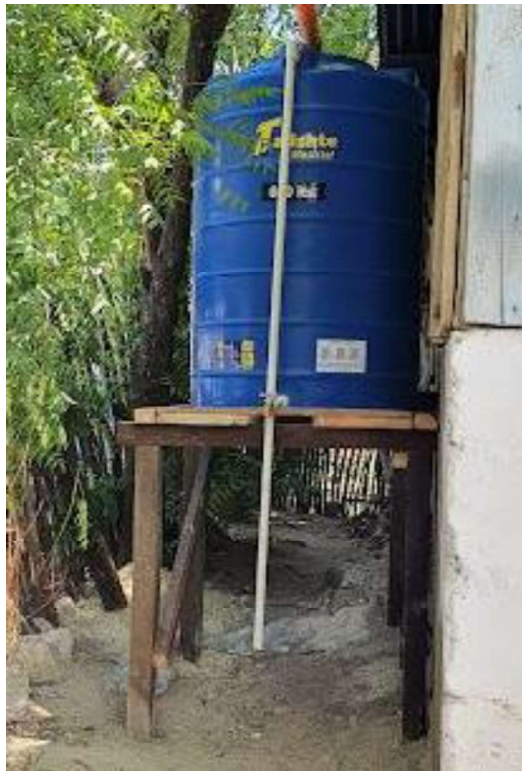
Figura 17. Instalación del tanque de almacenamiento de agua
