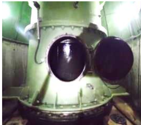
Figura 94. Pintura en interior del cono de aspiración con hulla de alquitrán
