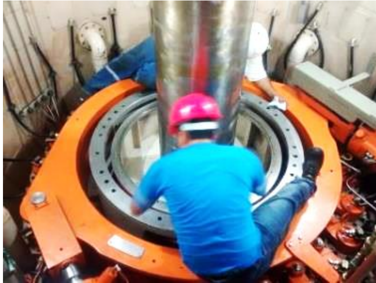
Figura 80. Limpieza en cuba de cojinete guía de turbina
