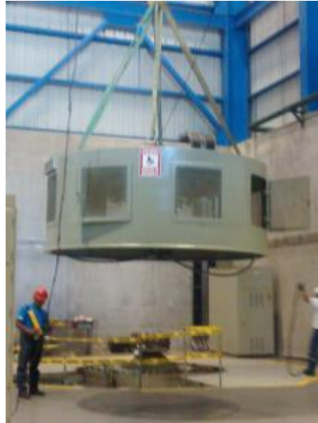
Figura 12. Izaje de protector de escobillas del Estator
