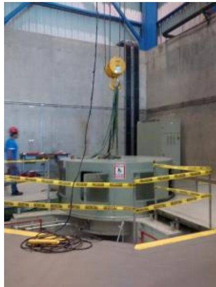
Figura 11. Desmontaje de tapas superiores del Estator
