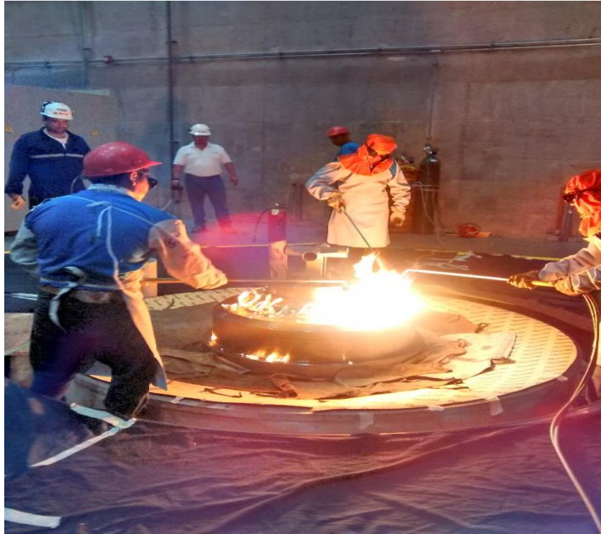
Figura 98. Calentamiento de bloque de empuje
