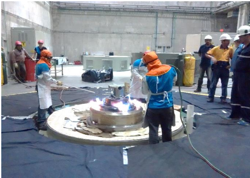
Figura 99. Protección del bloque de empuje
