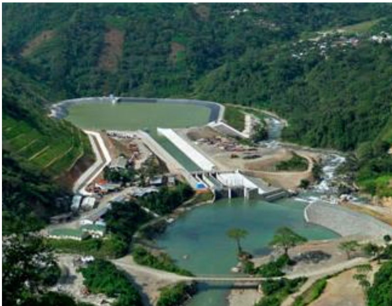
Figura 4. Central al aire libre, vista área de Hidro Xacbal, Guatemala
