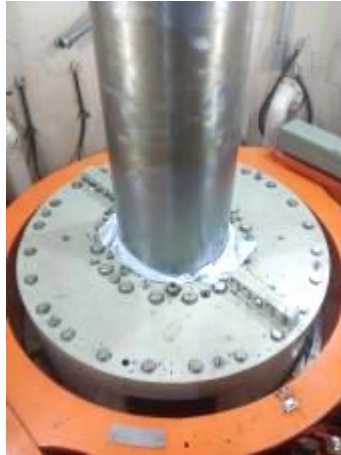
Figura 78. Desmontaje de instrumentación de cojinete guía de turbina
