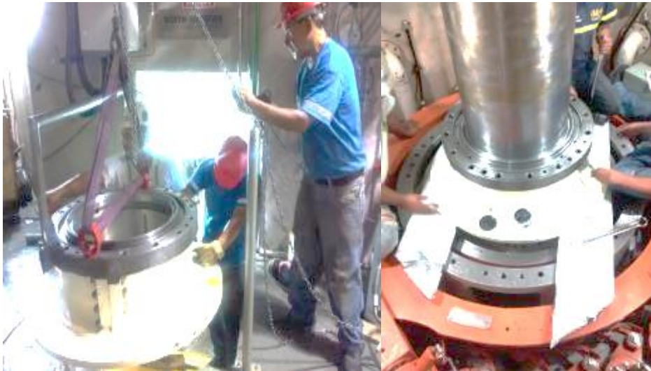
Figura 92. Montaje del repuesto del cojinete guía de turbina, después de limpiezas
