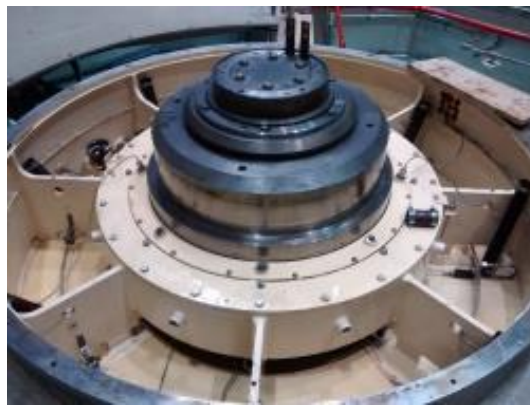
Figura 21. Desmontaje de instrumentación en cuba del cojinete del generador
