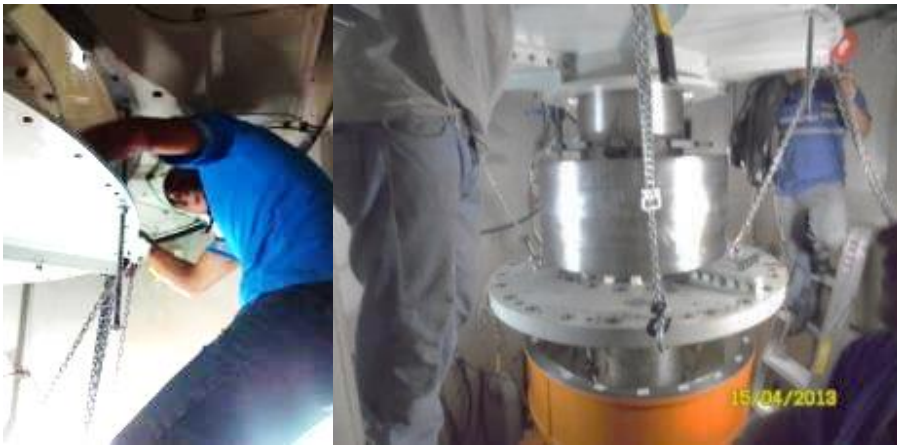
Figura 41. Desmontaje de instrumentación en cojinete guía inferior
