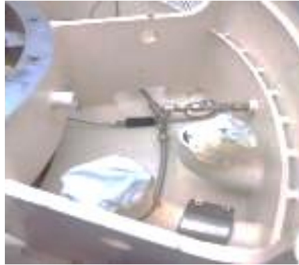
Figura 33. Instalación de válvula antiretorno
