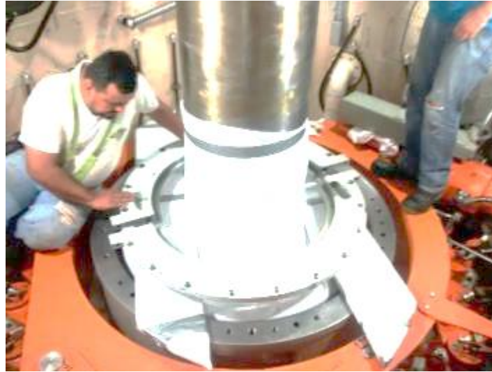
Figura 93. Montaje de tapas superiores del cojinete guía de turbina después de limpieza
