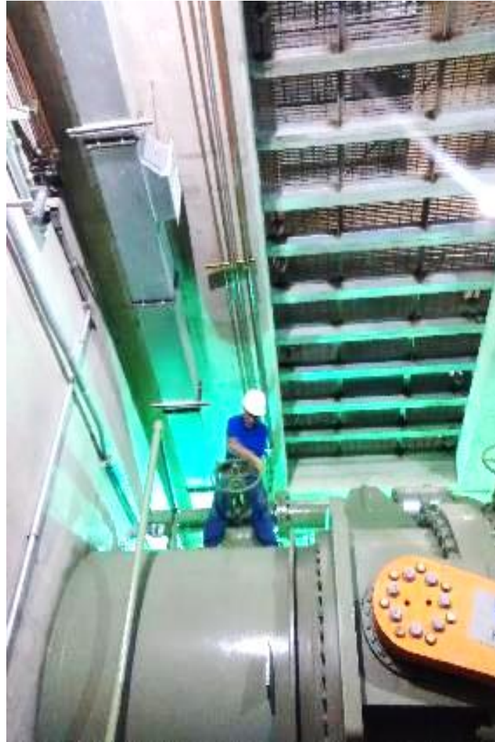
Figura 95. Cierre de válvula manual
