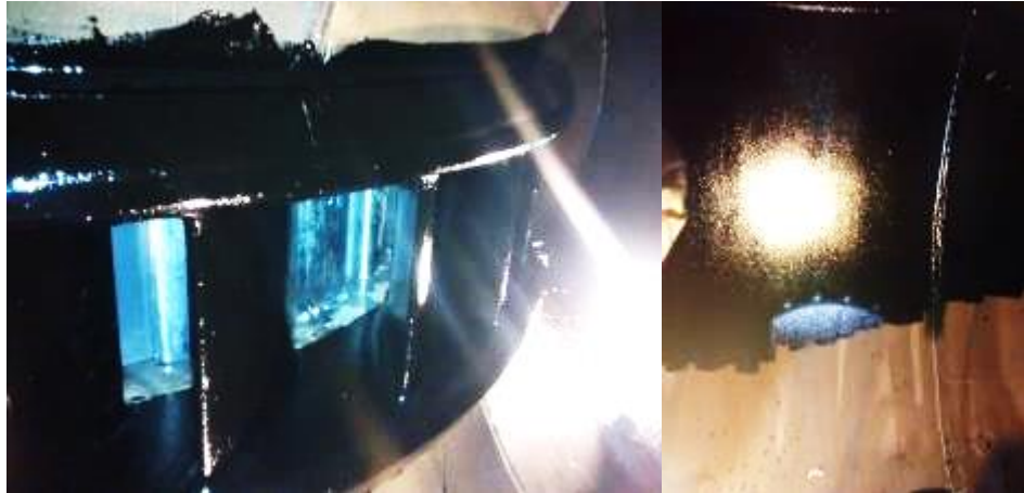
Figura 68. Limpieza y aplicación de hulla de alquitrán en cámara espiral
