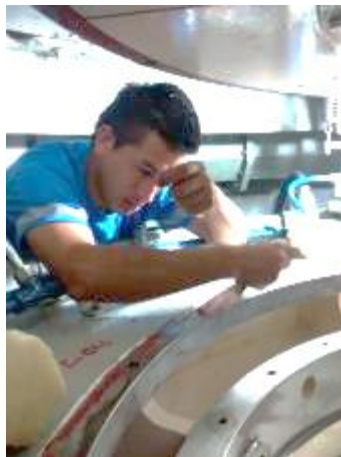
Figura 44. Limpieza de cuba en cojinete guía del generador
