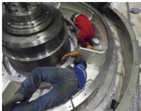
Figura 22. Apertura, vaciado de aceite y limpieza de cuba del cojinete combinado
