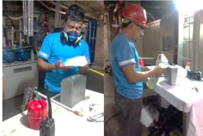
Figura 47. Limpeza y lubricación de cojinetes radiales
