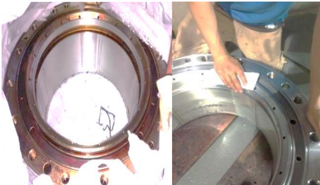
Figura 88. Limpeza de cojinete guía de turbina de repuesto
