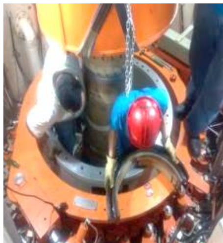
Figura 84. Desmontaje de sello mecánico del cojinete guía
