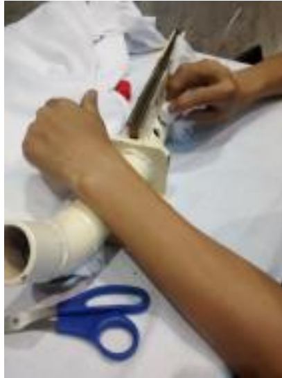
Figura 25. Desmontaje, revisión y limpieza de tubería de paso de aceite (flautas)
