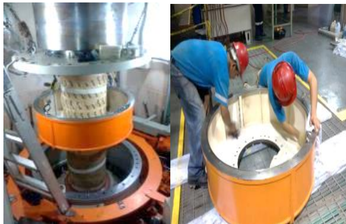
Figura 83. Desmontaje y limpieza de tapa de cojinete guía de turbina
