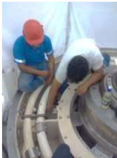
Figura 38. Instalación de tubería de aceite en cuba de cojinete combinado
