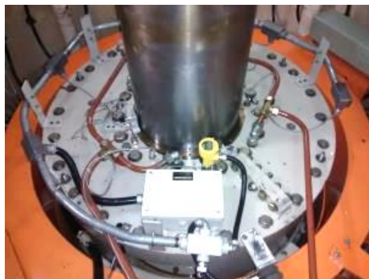
Figura 77. Cojinete guía de turbina
