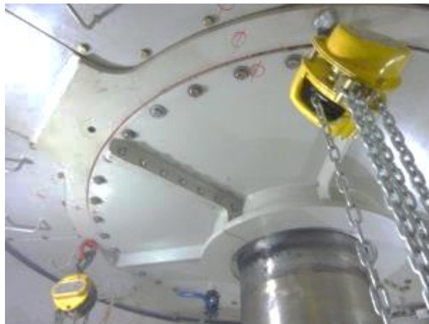
Figura 48. Cierre de cuba inferior en cojinete guía
