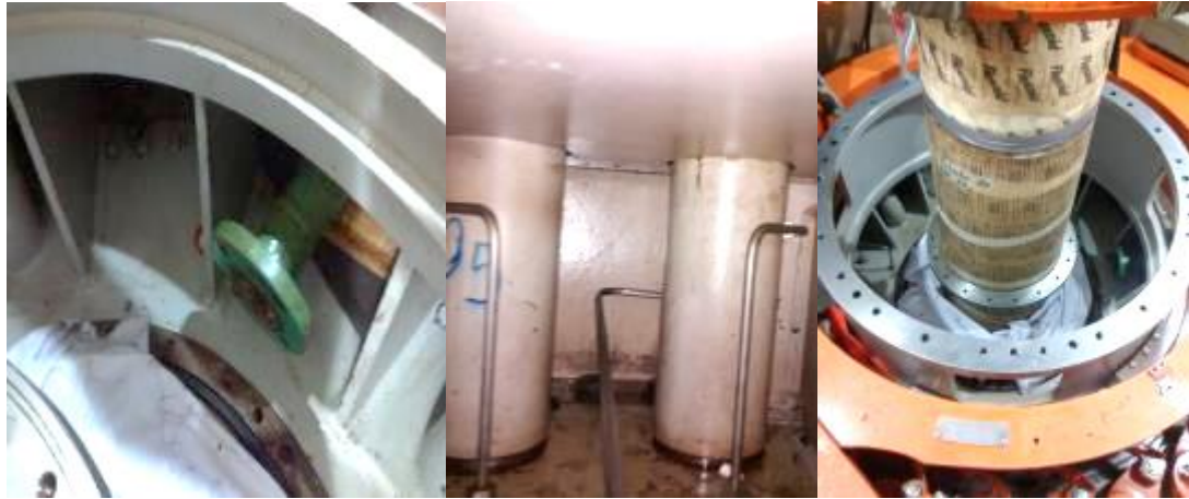
Figura 89. Limpieza final en cuba de cojinete guía de turbina
