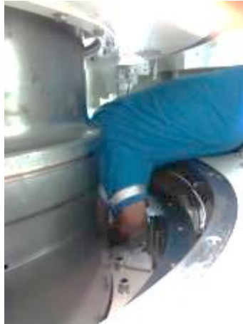
Figura 43. Limpieza de aceite en cuba de cojinete guía inferior
