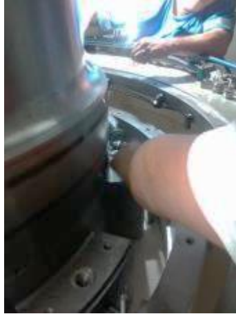
Figura 49. Montaje de cojinetes radiales del cojinete guía
