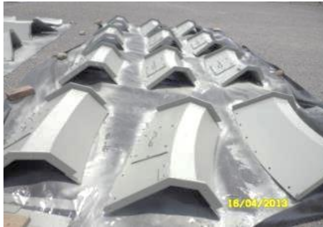
Figura 52. Limpieza y pintura de visores de cabezas de bobina
