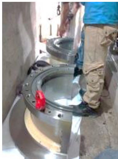
Figura 81. Desmontaje de cojinete guía de turbina
