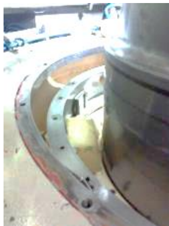
Figura 42. Apertura, vaciado de aceite en cuba de cojinete guía inferior
