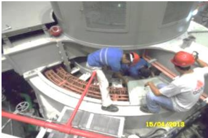
Figura 51. Desmontaje de visores de cabezas de bobina
