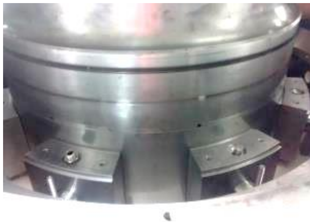
Figura 50. Instalación y lubricación de cojinetes radiales del cojinete guía
