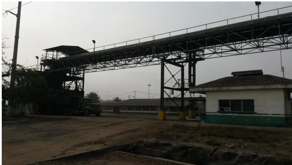
Figura 18. Tolva receptora de trash
