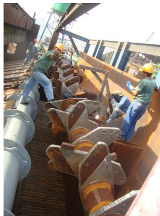
Figura 30. Montaje de troceadoras
