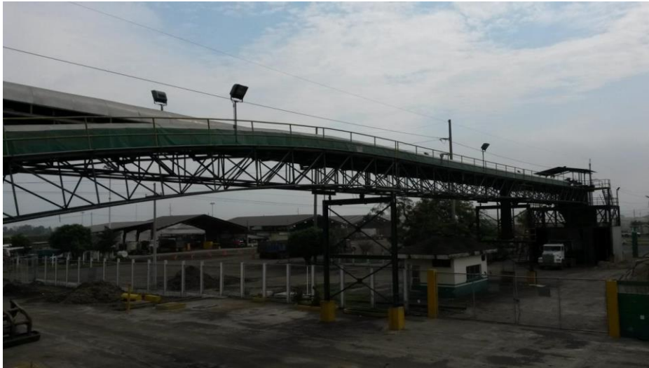
Figura 17. Conductor C de banda para salida de trash
