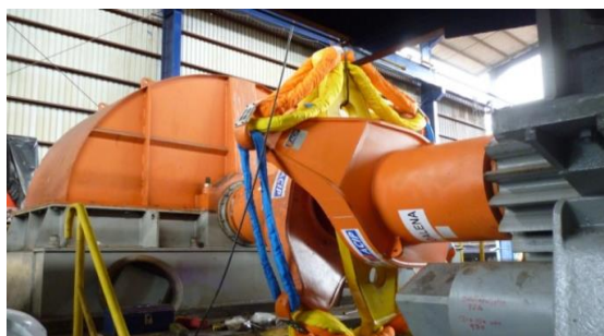
Figura 73. Montaje de eslingas de trabajo y de seguridad de parte inferior de sistema de acople flexible
