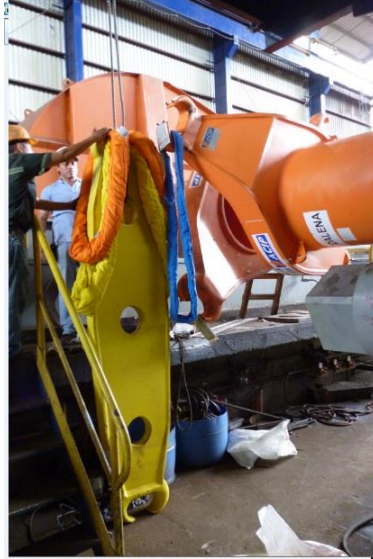
Figura 67. Montaje de elemento flotante de sistema de acople flexible
