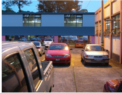
Figura 8. Imagen de la fachada del edificio de las instalaciones del nuevo laboratorio (vista posterior).
