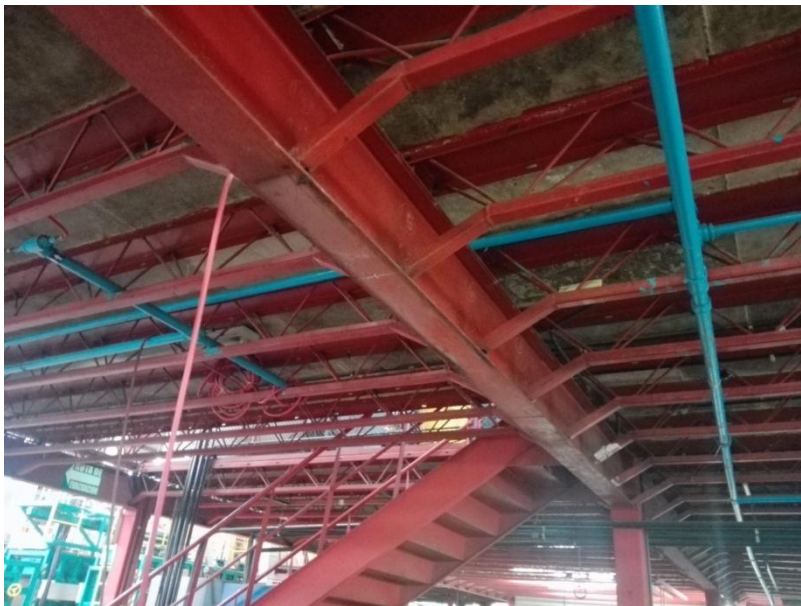
Figura 9. Identificación de tuberías de aire comprimido en la planta
