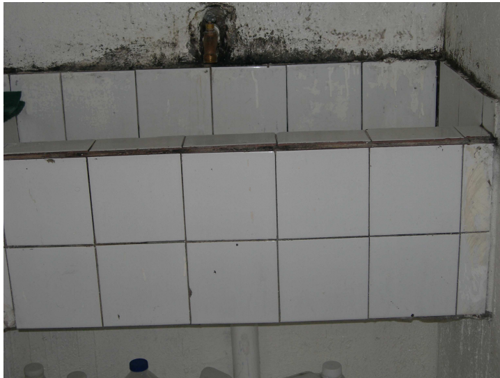
Figura 26. Base para determinar los puntos críticos de control, en el área de envasado
