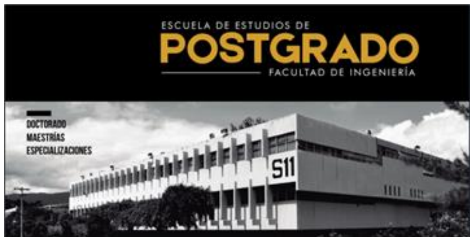
Figura 16. Vista exterior del edificio S-11
