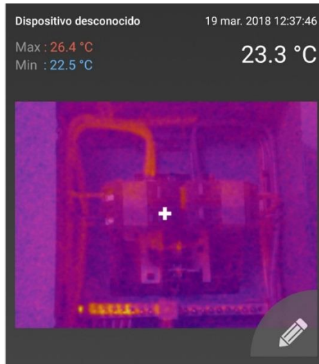
Figura 51. Termografía T-BIB
