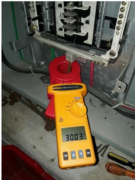
Figura 42. Medición de tierra física MUNAE
