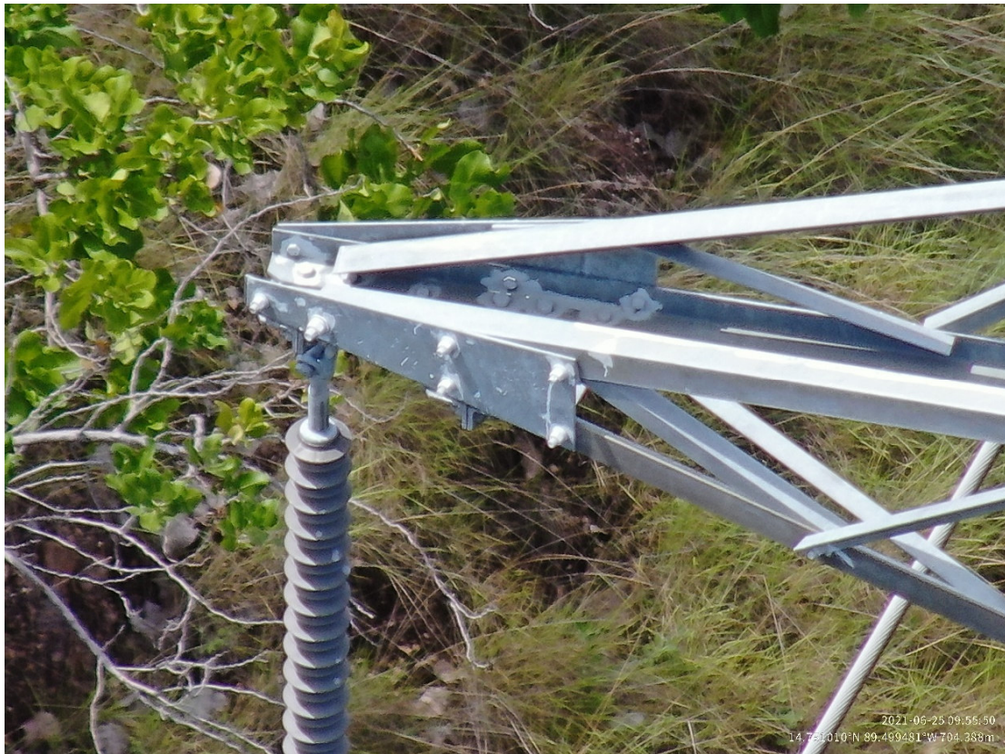
Figura 32. Hallazgo en cadena de aislador en suspensión, daño por descarga electro atmosférica
