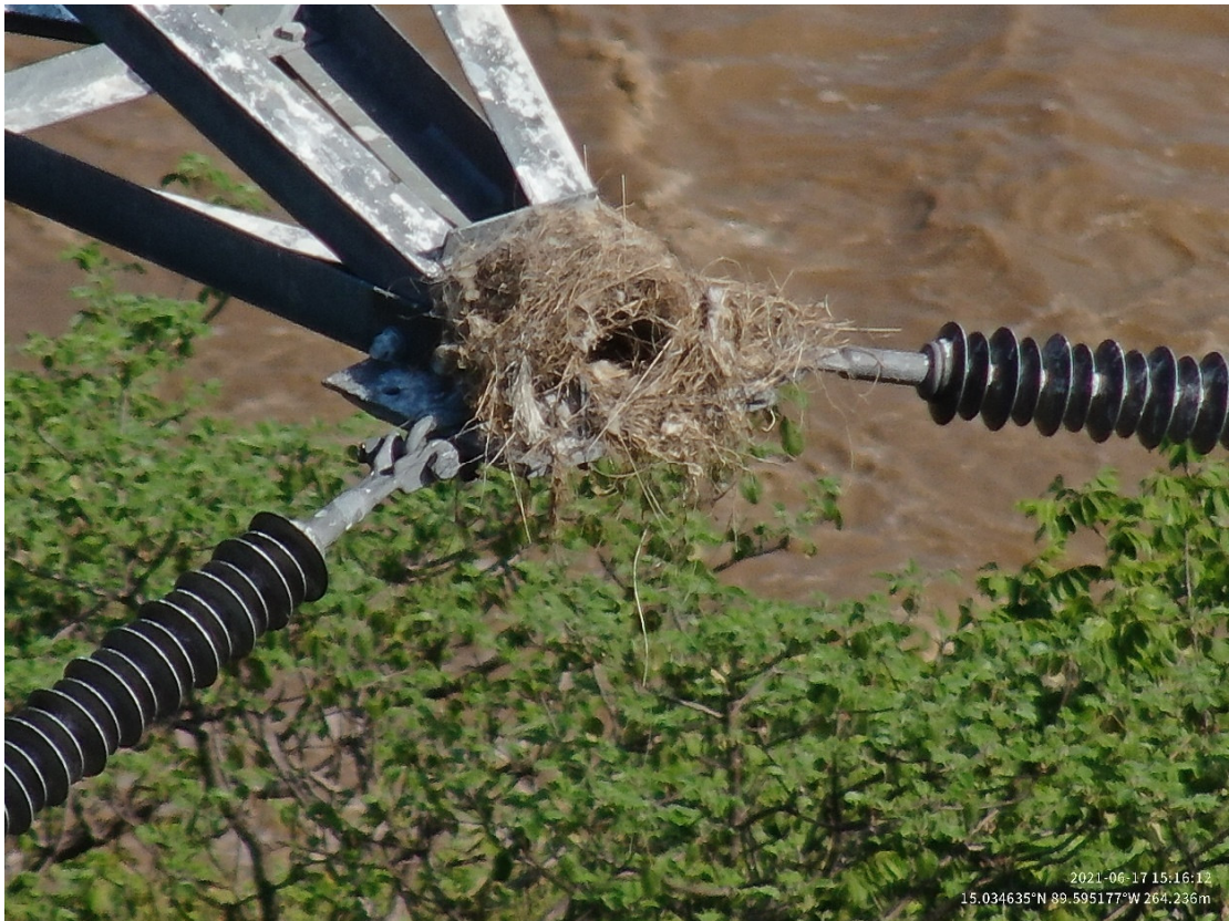
Figura 31. Hallazgo en estructura, contaminación por nido de aves
