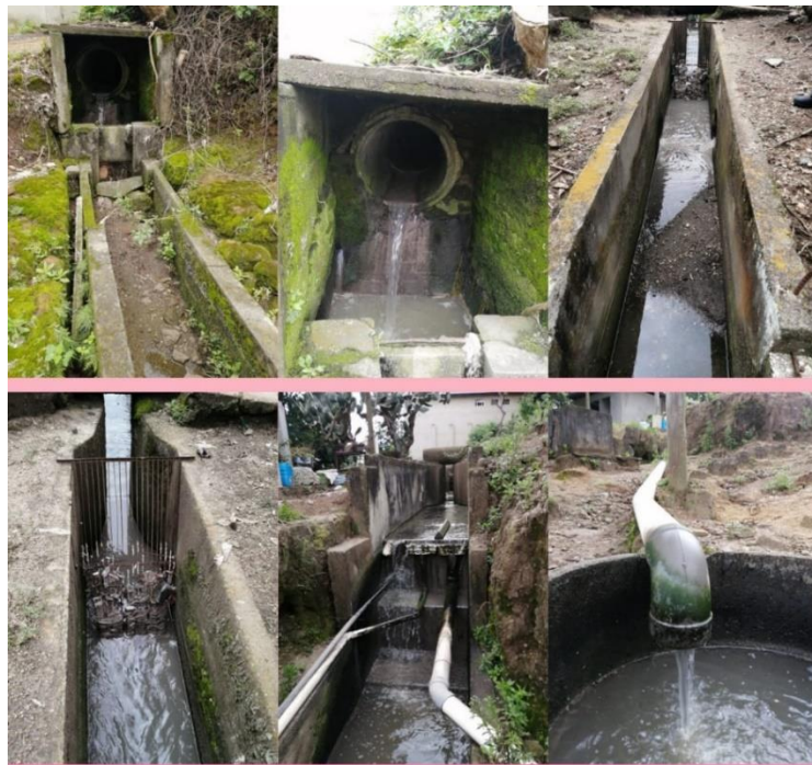
Figura 9. Salidas de agua residual doméstica de la colonia La Aurora II
