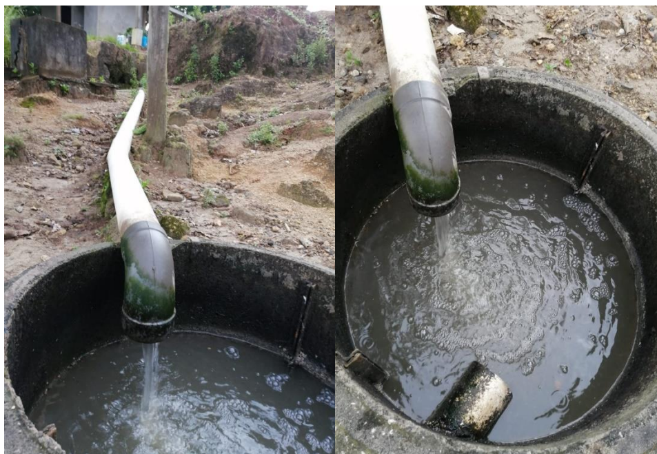
Figura 4. Salida de agua residual doméstica de la colonia La Aurora II
