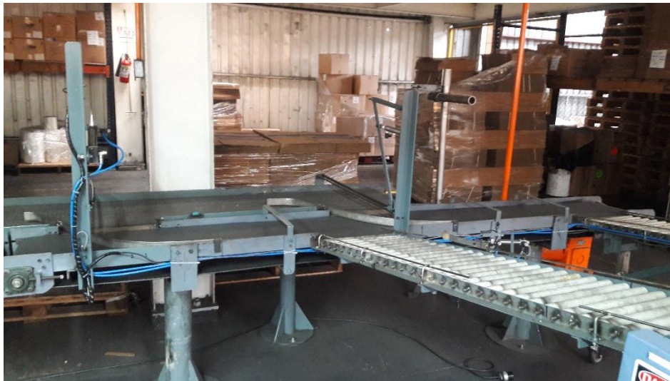
Figura 45. Instalación de bandas trasportadoras secundarias
