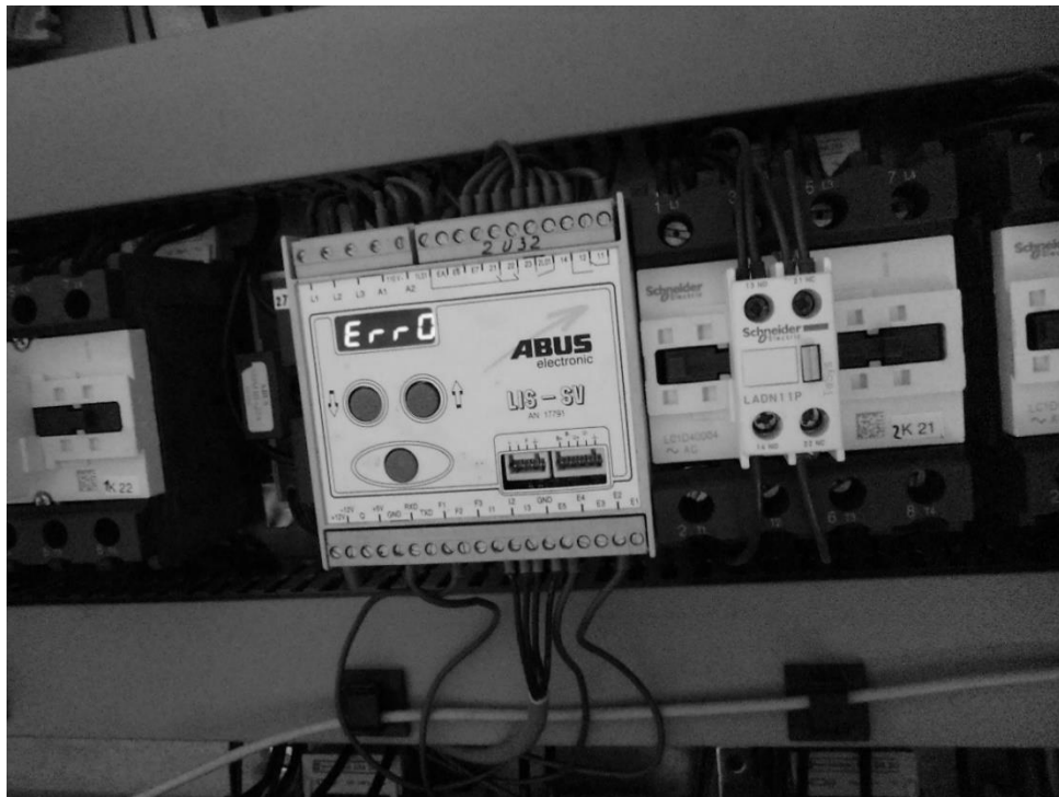
Figura 13. Sistema indicador de cargas con sobrecarga eléctrica
