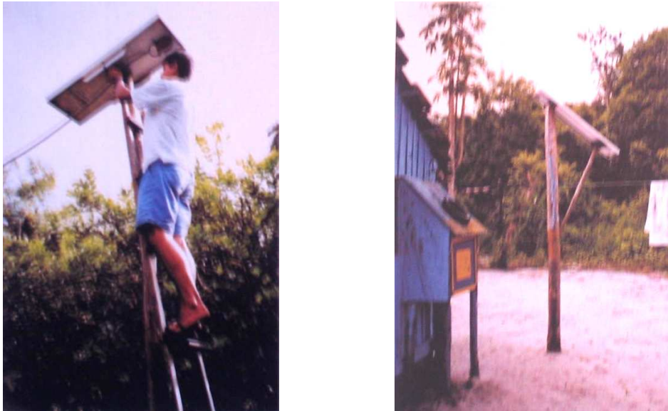
Figura 41. Ejemplos del montaje de los módulos fotovoltaicos
