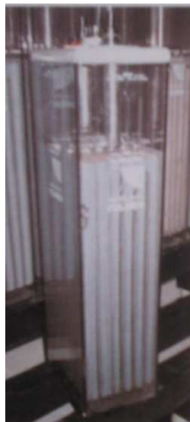
Figura 17. Baterías: Elemento típico de 2 V y 1800Ah, de electrolito líquido (izquierda); banco de baterías formado por 6 elementos y 2 V, conectados en serie (derecha)
