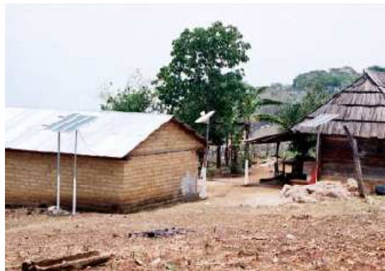
Figura 36. Ejemplo de la instalación de módulos fotovoltaicos en una comunidad rural
