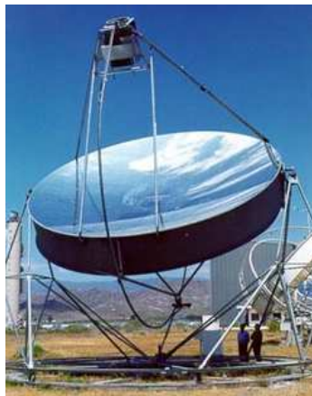
Figura 4. Colector solar tipo disco parabólico para una central solar térmica de alta temperatura
