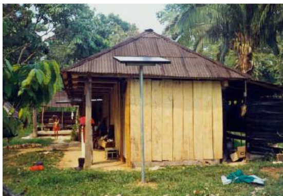
Figura 32. Ejemplos de instalación de paneles fotovoltaicos en comunidades rurales para iluminación de viviendas (izquierda) e iluminación pública (derecha)
