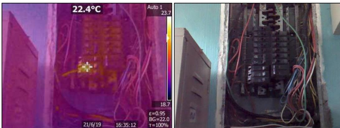
Fuente: elaboración propia, empleando cámara termográfica Fluke TiS45.
