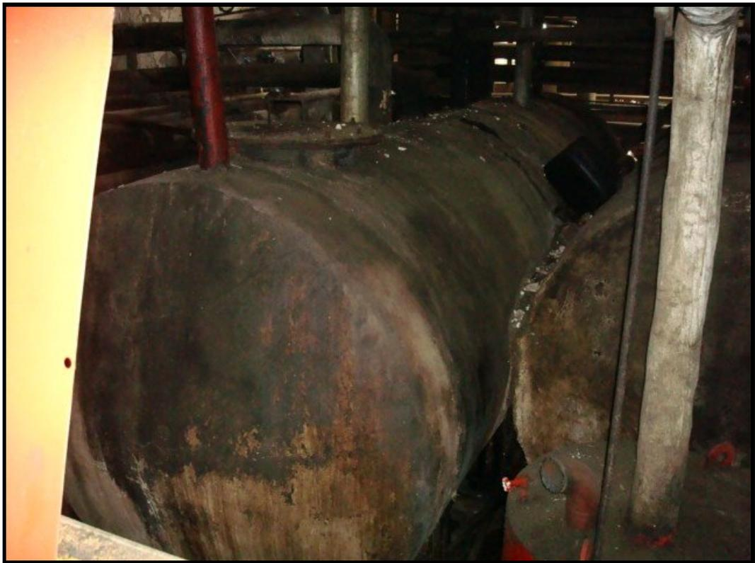
**Figura 26.** Tanque de condensados fríos
