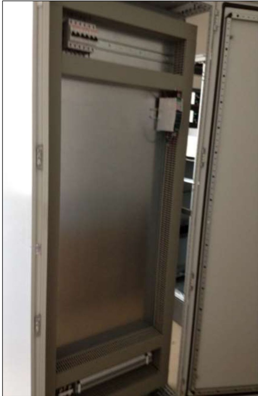
Figura 143. Placa trasera de panel de control local
