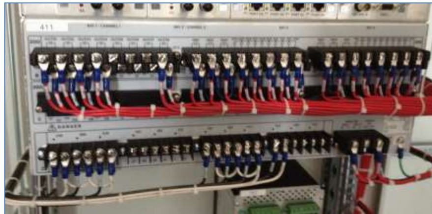
Figura 121. Detalle de terminales tipo ojo
