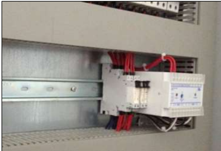
Figura 133. Detalle de relevador de evaluación de sincronismo
