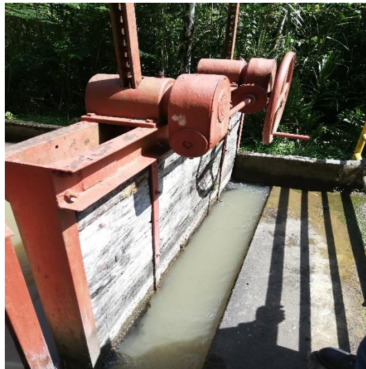
Figura 12. Compuerta del desarenador
