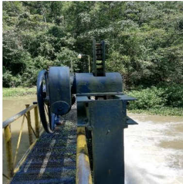
Figura 8. Mecanismo compuerta de canal de conducción
