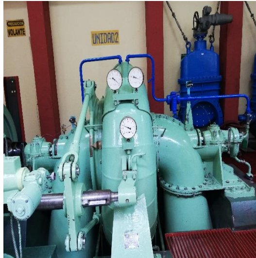
Figura 26. Tubos de aspiración turbina Francis
