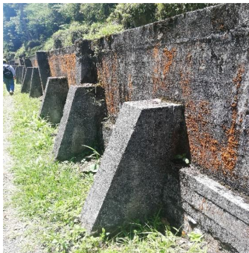
Figura 14. Reforzamiento en los cimientos del canal
