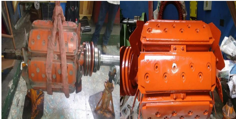
Figura 33. Mantenimiento al generador
