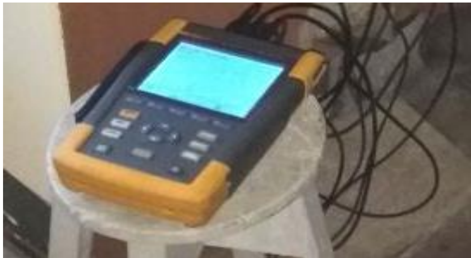
Figura 37. Instalación de analizador de redes
