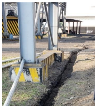
Figura 16. Instalación de tubería para descarga
