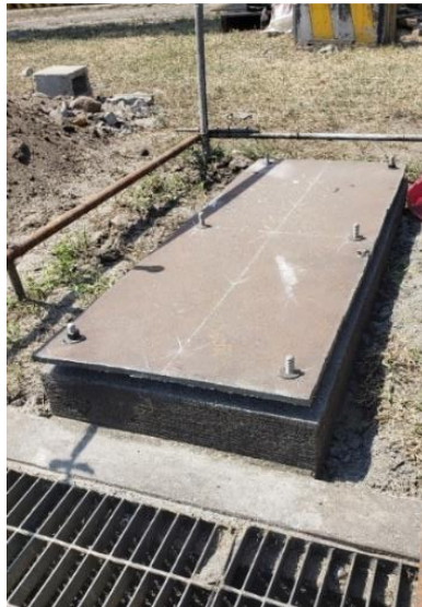
Figura 14. Bancazo de motor-bomba
