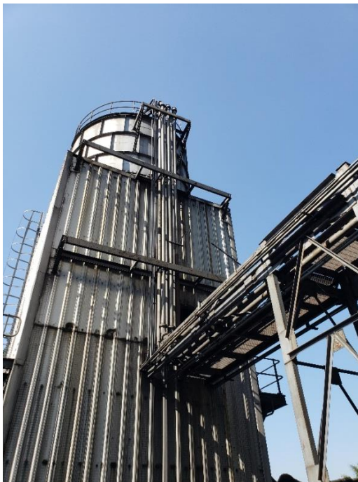
Figura 9. Silo de ceniza
