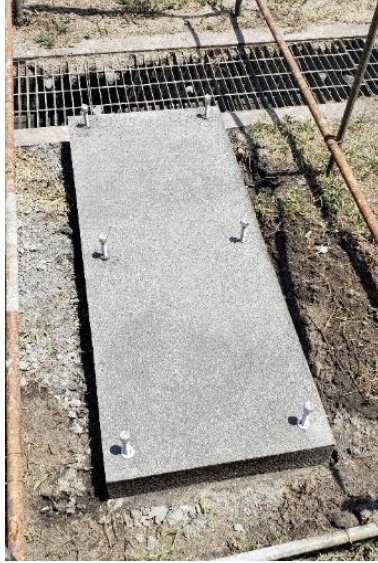
Figura 13. Aplicación de grouting para bancazo
