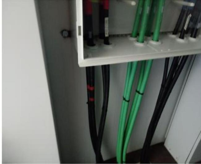
Figura 7. **Cables celdas solares hacia inversor (cableado D.C.)**
