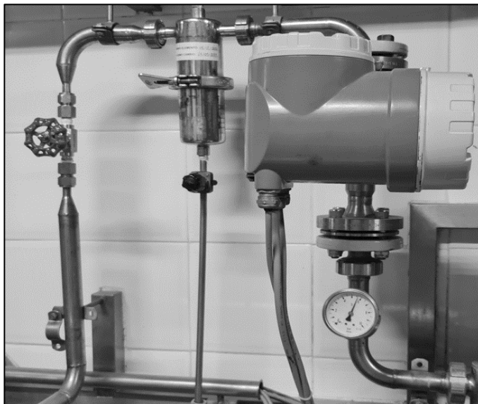
Figura 11. Instalación control inyección de aire a proceso
