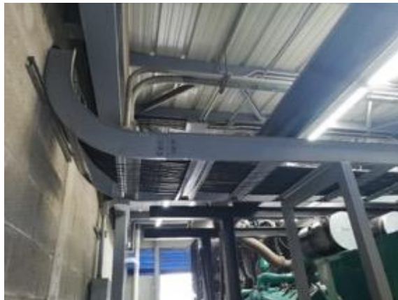
Figura 13. Canaleta tipo escalera
