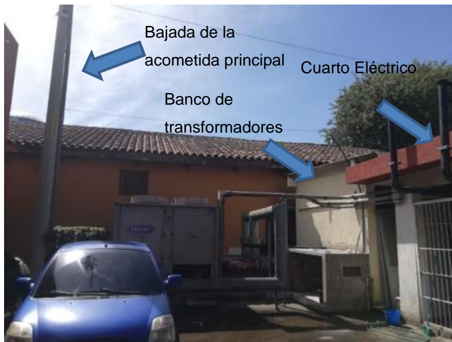
Figura 47. Ubicación de transformadores y subestación eléctrica
