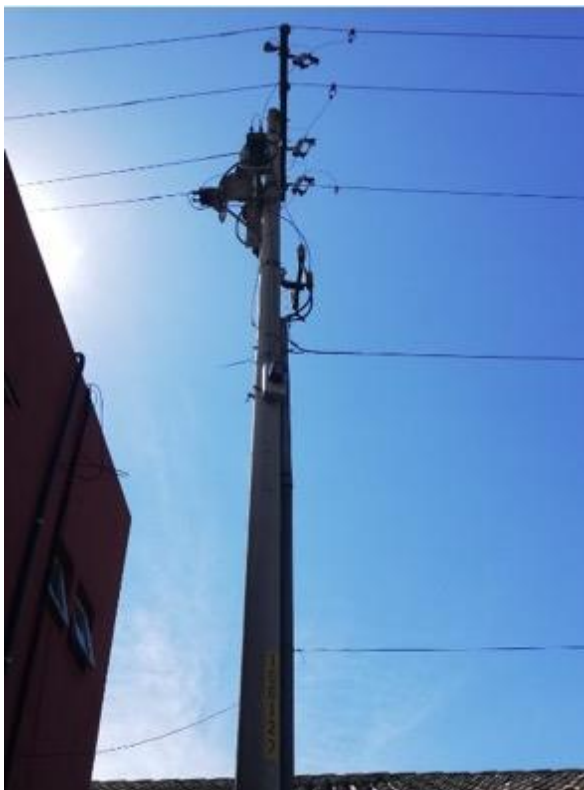
Figura 46. Acometida principal del Minex
