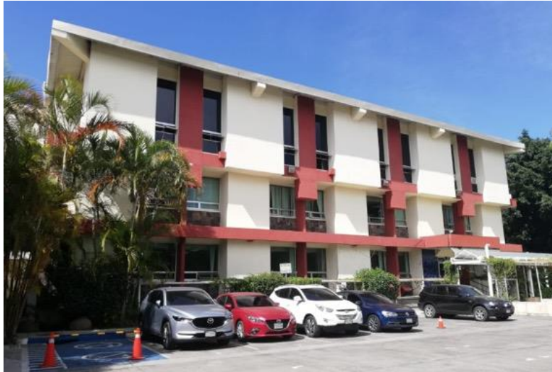
Figura 43. Edificio lado sur
