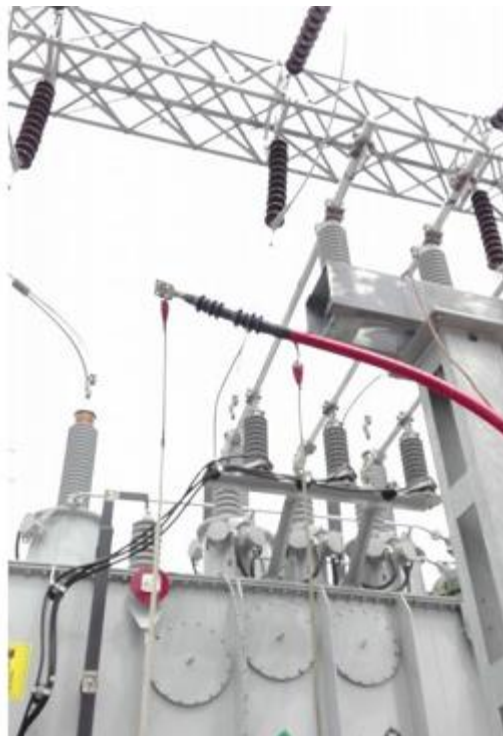
Figura 8. Prueba de Hi-Pot a terminal mufa 69 kV
