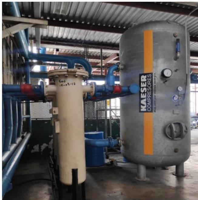
Fuente: Instalaciones de Tennat, S. A. Área de tanques de almacenamiento de aire comprimido de 5 000 litros.
