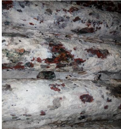
Figura 27. Tubos de humo caldera Kewanee Boiler
