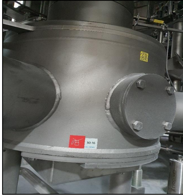
Figura 26. Ubicación de los puntos de engrase del acoplamiento
