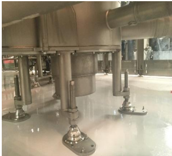
Figura 40. Ubicación de servomotor del rodamiento principal
