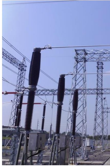
Figura 8. Interruptor tripolar de potencia
