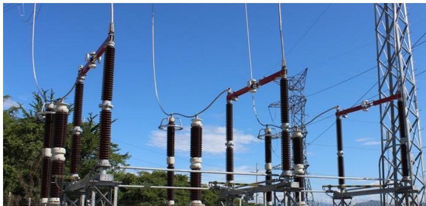
Figura 9. Seccionadores de línea de apertura central
