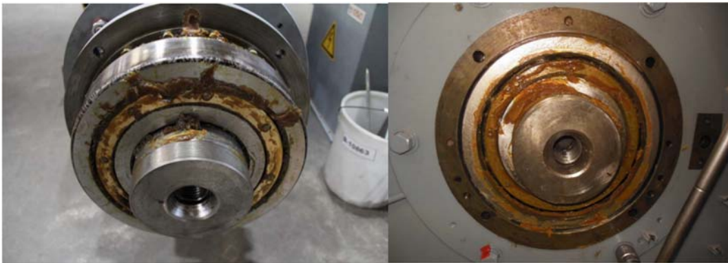
Figura 94. Condición de la grasa punto A tras el desarme
