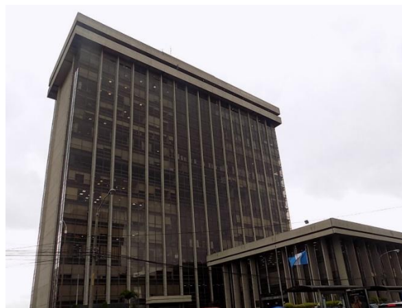
Figura 34. Envolvente edificio Anexo y La Torre, fachada noreste, mampostería y vidrio
