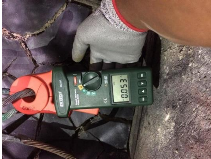
Figura 97. Medición de tierra en caja de registro de malla
