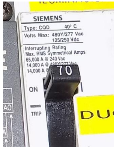
Figura 19. Interruptor MCCB serie COD, con una corriente máxima de operación de 70 amperios y una corriente de interrupción simétrica clasificación NEMA de 65 kA
