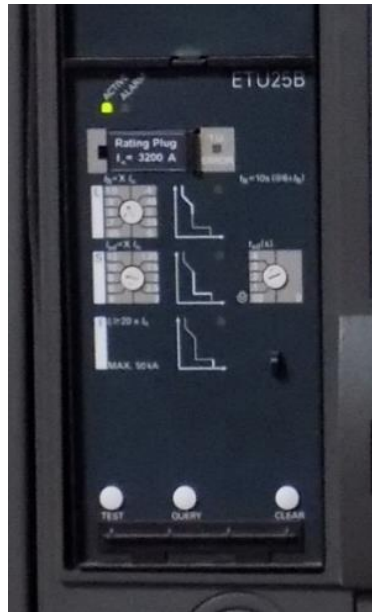
Figura 17. Set para ajuste de disparo (curvas) para coordinación de protecciones del interruptor tipo ACB serie ETU 25B marca Siemens
