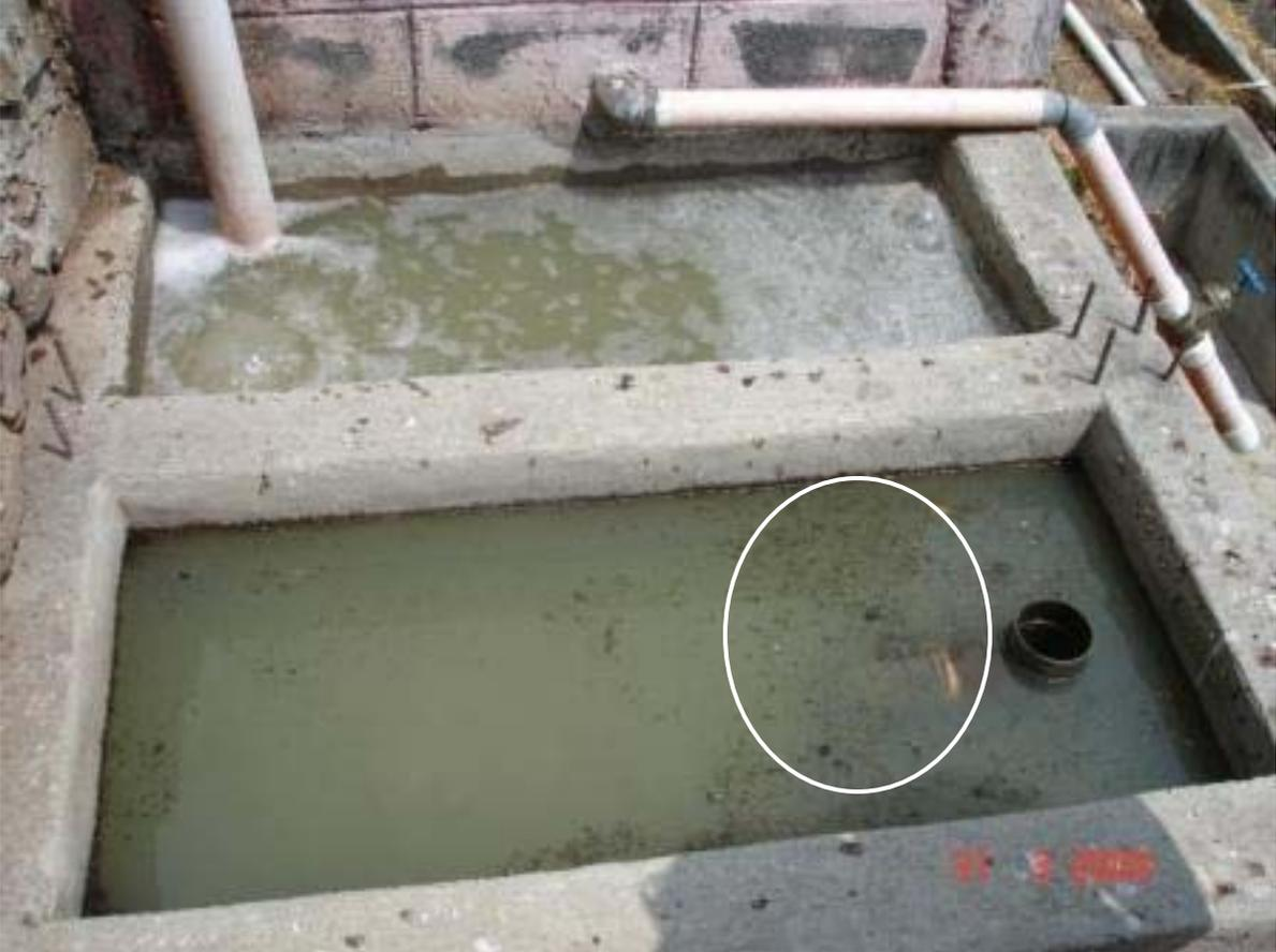
**Figura 16. Fotografía Tubería de salida de sedimentadores hacia patio de secado de lodos.**
