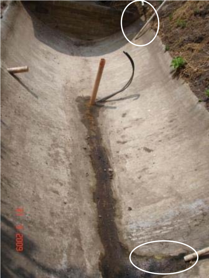
Figura 20. Fotografía tanque de oxidación
