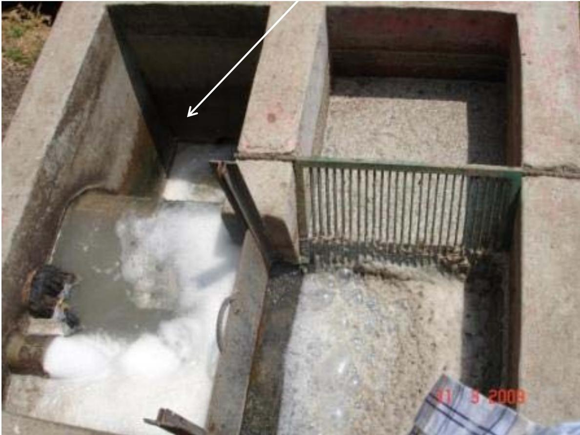
Figura 13. Fotografía trampa de sólidos y desarenador.
