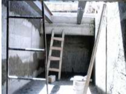
Figura 17. Fosa del sistema de recepción de materia prima a granel
