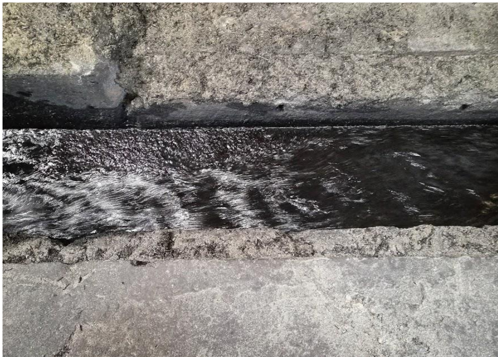
Figura 6. Canal para transporte de ceniza
