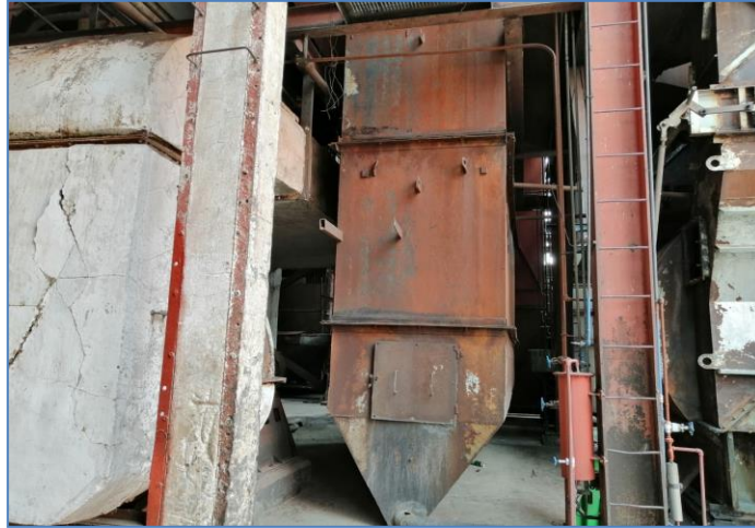
Figura 21. Fotografía del montaje del depurador de gases
