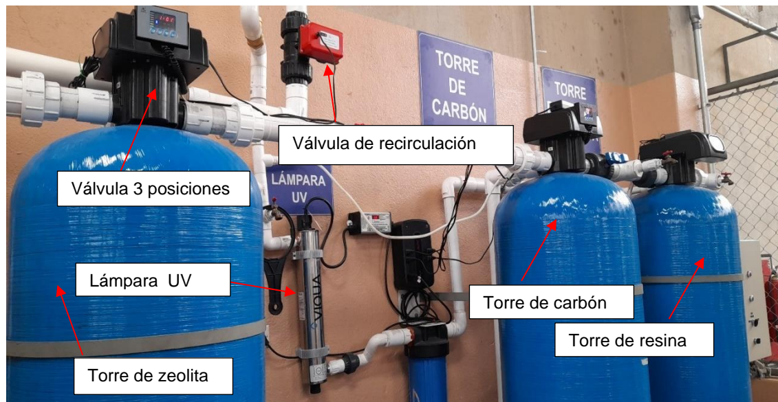
Figura 6. Sistema de tratamiento de agua potable
