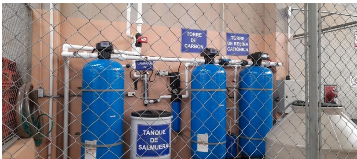
Figura 1. Sistema de tratamiento de agua potable
