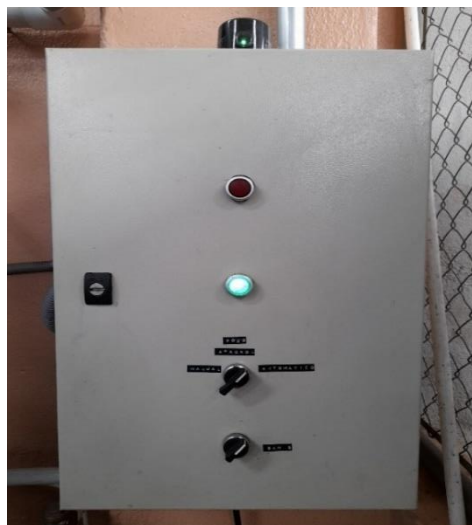
Figura 11. Panel de control de bomba principal y sistema automático
