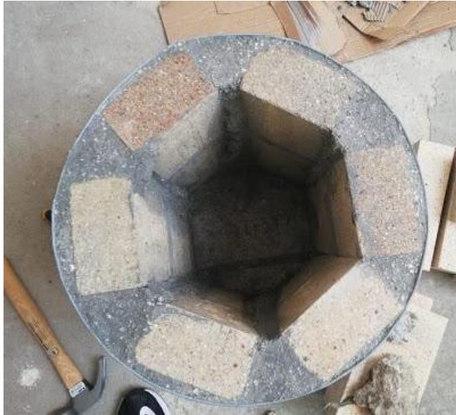
Figura 29. Vista final del cuerpo del horno
