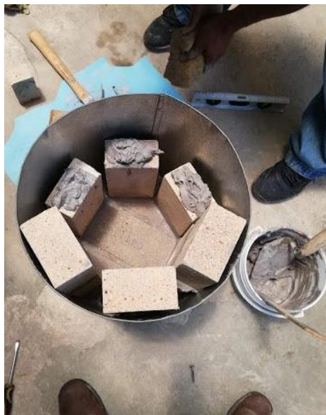
Figura 28. Pegado de ladrillos dentro del cuerpo metálico
