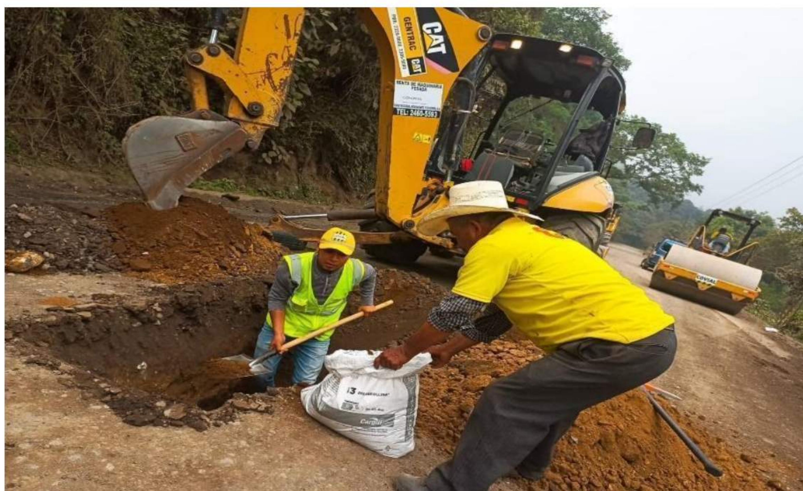
Figura 1. Extracción de muestras para laboratorio análisis de laboratorio
