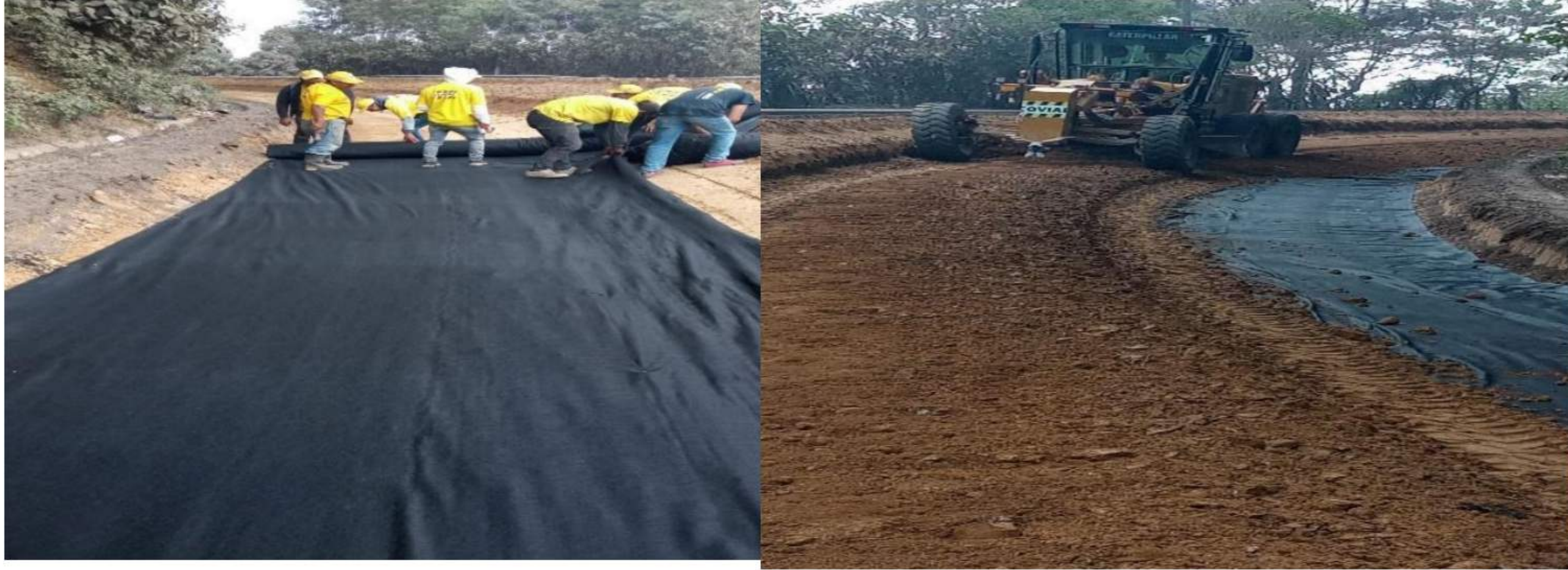
Figura 5. Colocación de geotextil en subrasante
