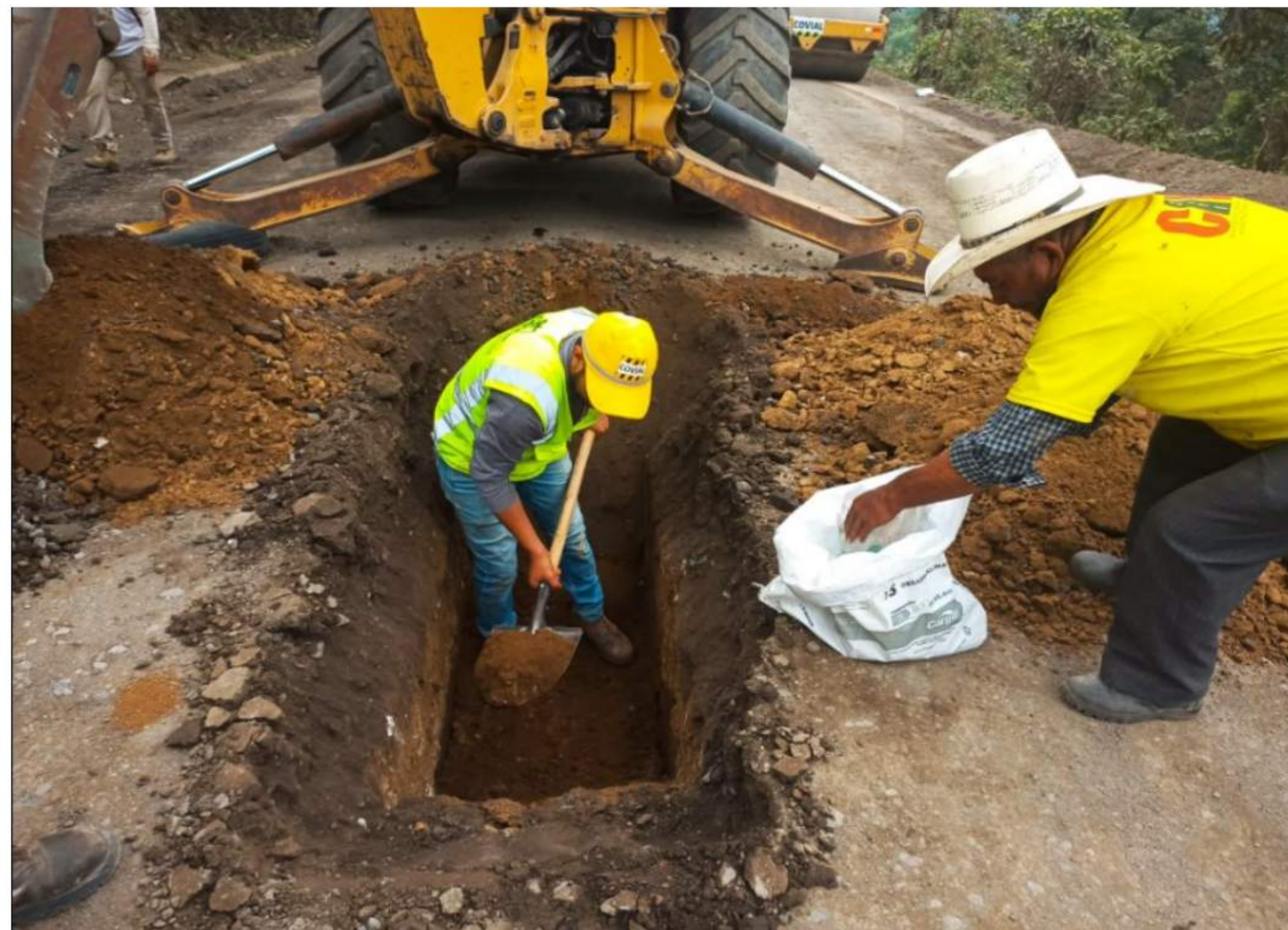
Figura 2. Extracción de muestra para los estudios de laboratorio
