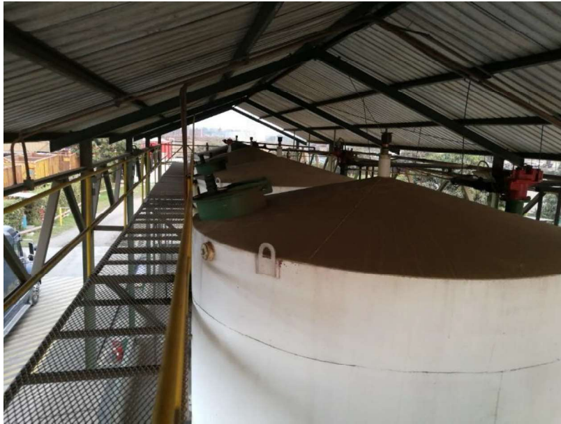
Figura 39. Tanques para almacenamiento de combustible diésel
