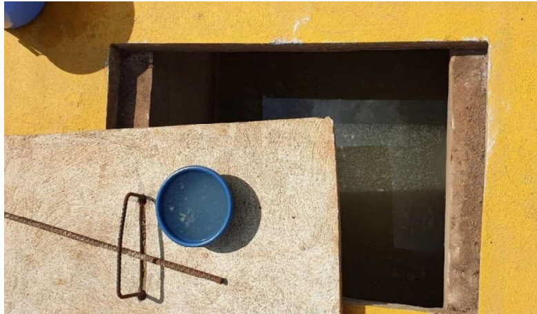
Figura 50. Pozo de absorción
