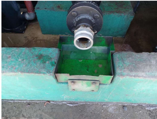
Figura 46. Bandeja de contención en cuarto de bombas
