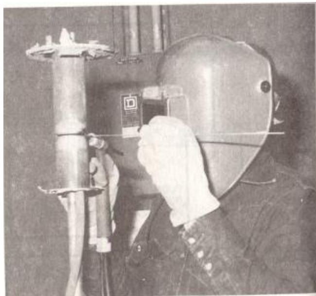
Figura 23. Soldadura manual de tig de una unión de tubería
