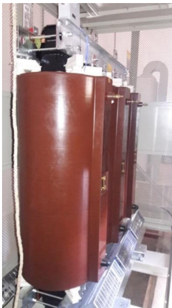
Figura 13. Transformador seco
