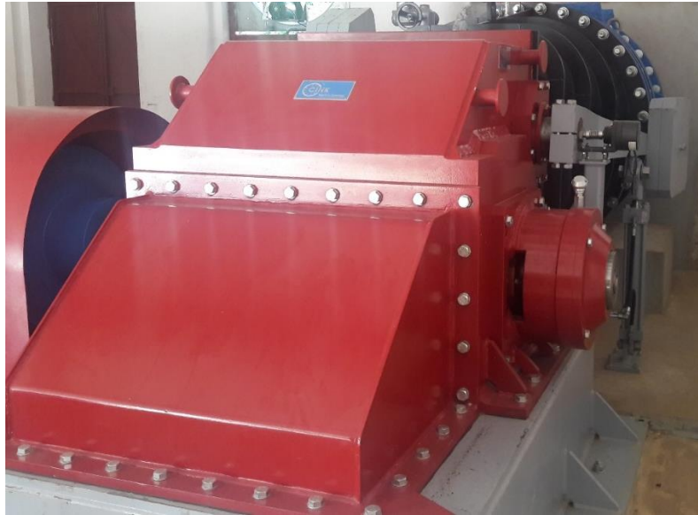
Figura 9. Turbina crossflow de dos cámaras
