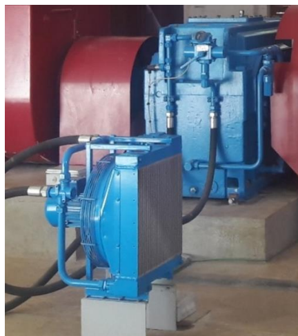
Figura 10. Caja multiplicadora y sistema de refrigeración
