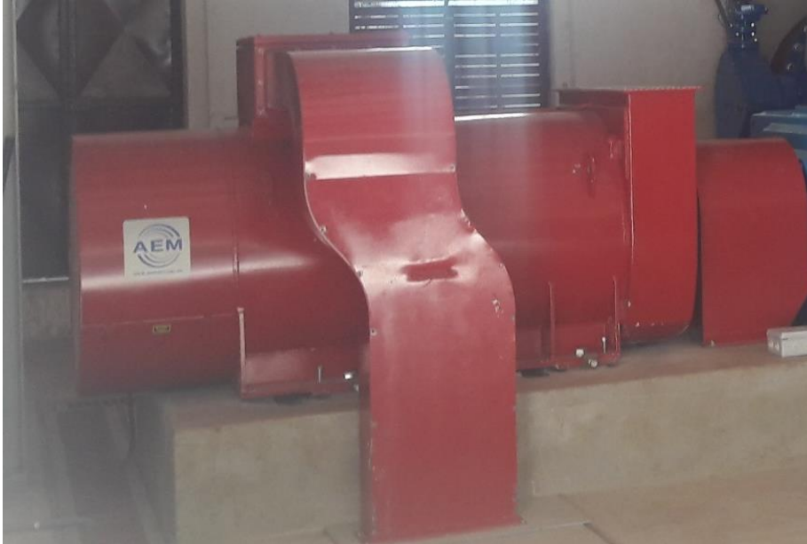
Figura 11. Generador síncrono
