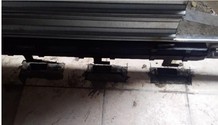
Figura 45. Montaje del faldón
