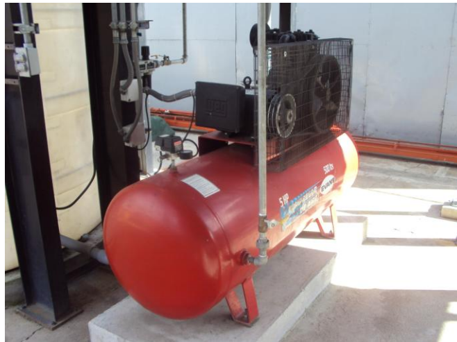
Figura 18. Fotografía 5. Bombas de succión del tanque de lodos
