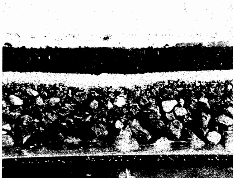
Figura 31. Capas del filtro piloto
