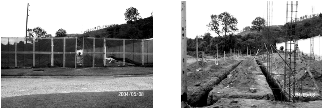
Figura 7. Trabajos preliminares del centro comercial
