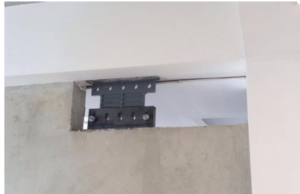
Figura 11. Disipadores SLB en muros desacoplados
