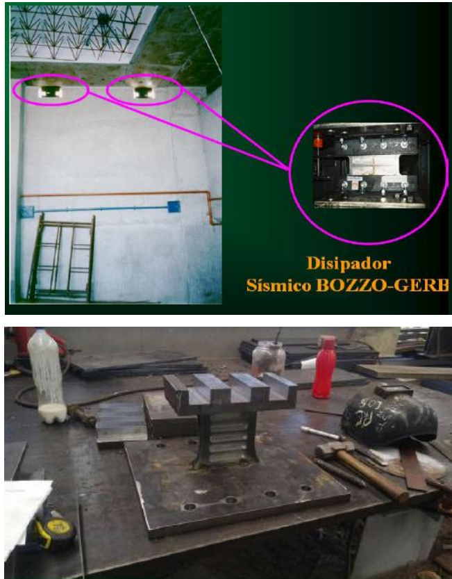
Figura 8. Disipador sísmico SLB
